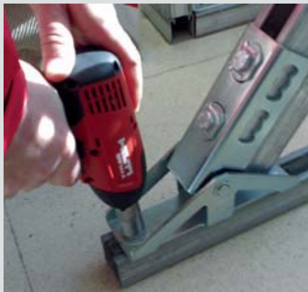
Atornilladora a batería Hilti SIW 144-A Litio CPC Rapidez y facilidad en el montaje de soportes
