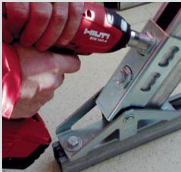
Atornilladora a batería Hilti SIW 144-A Litio CPC Rapidez y facilidad en el montaje de soportes
