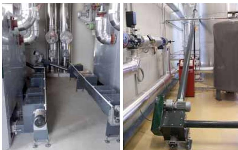
En esta imagen pueden observarse los depósitos de cenizas conectados mediante el sistema sinfín, una solución de 2 calderas en cascada HERZ.
